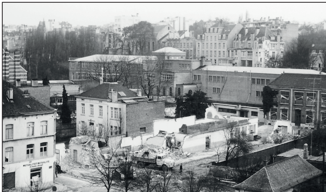
Démolition des locaux de l'ancienne école paroissiale, rue du Doyenné, vers 1970.
