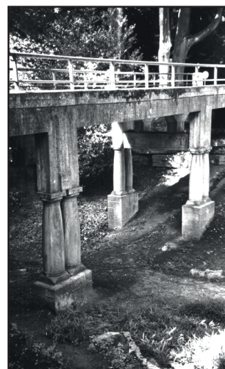
Pont transformé, la partie en bois remplacée par du béton armé. Visite du 5 septembre 2003. Photo Raymond Balau.
