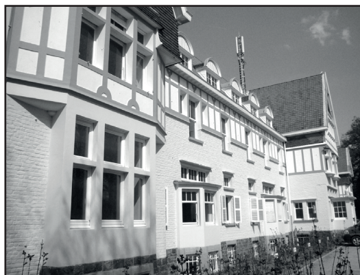
Vue du bâtiment principal rénové, 2009.
