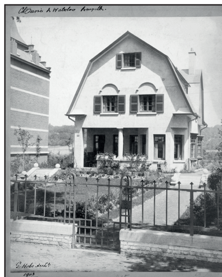
Photographie de la villa Thiry rue de la chaussée de Waterloo, 1903. CIVA Collections Brussels, Fonds Georges Hobé. Reproduction Luc Schrobiltgen.
