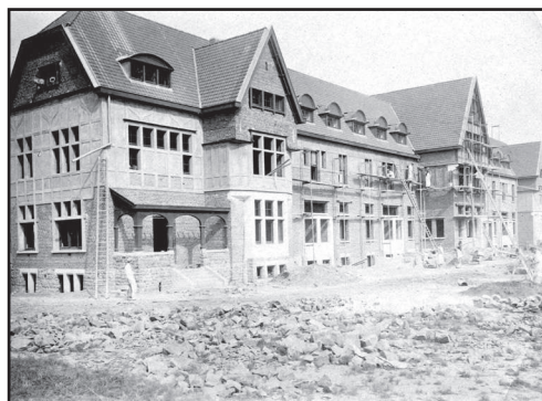
Vues du chantier du bâtiment principal,
