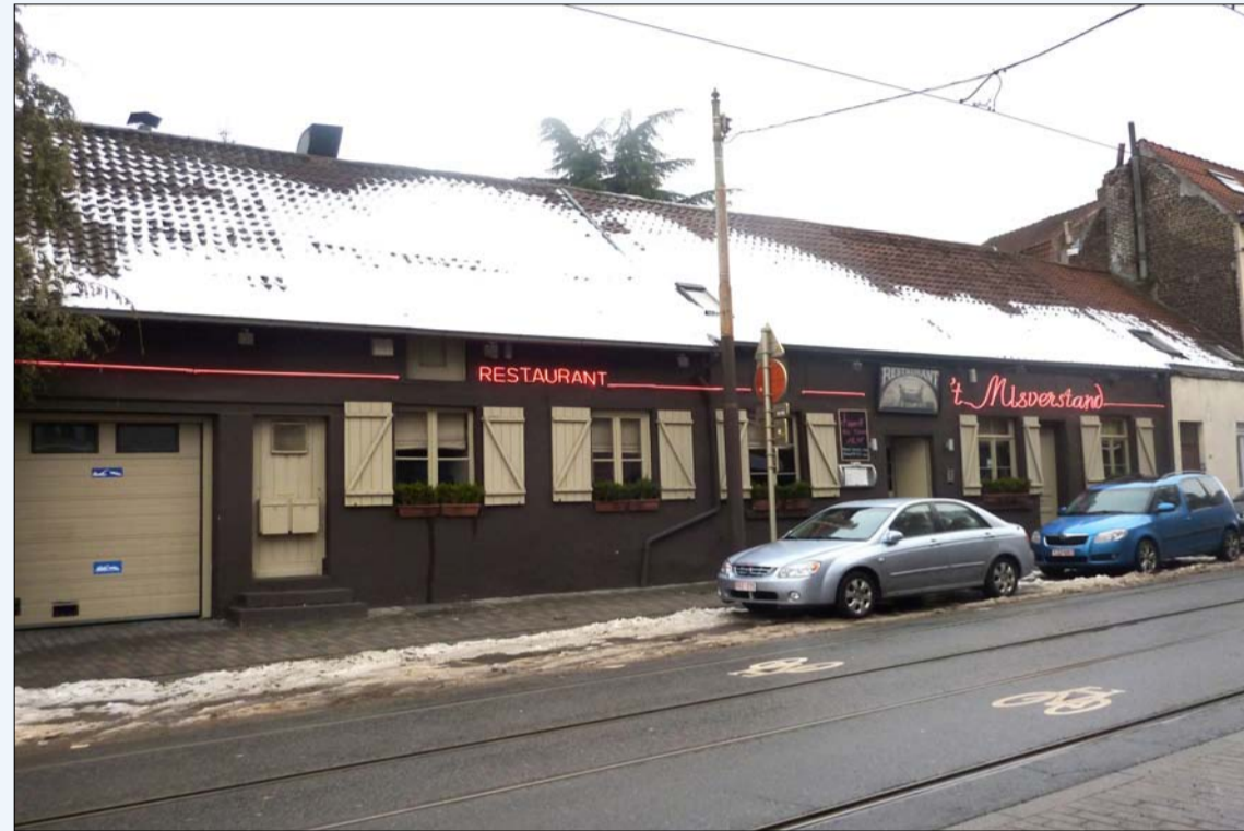
Vue du restaurant 't Misverstand, fermé depuis plus de deux ans. Photo 2010.
