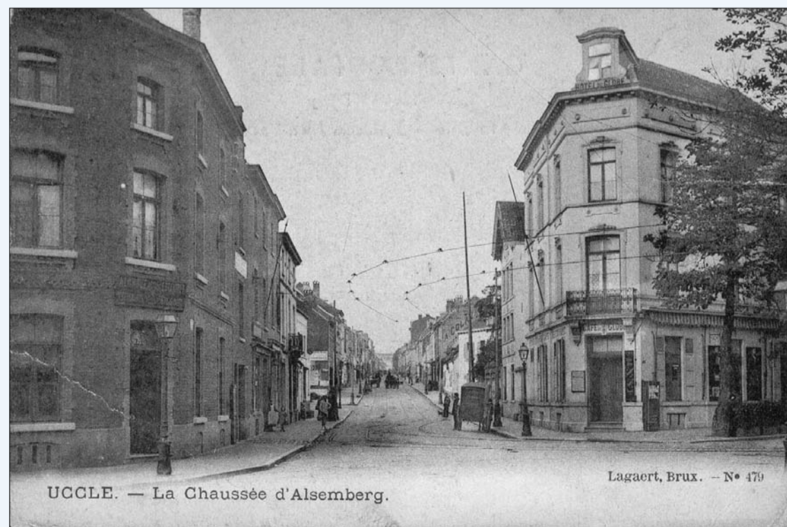
Vue ancienne du carrefour, vers le centre d'Uccle (autour de 1900). A droite, le Café du Globe . Coll. YB.
