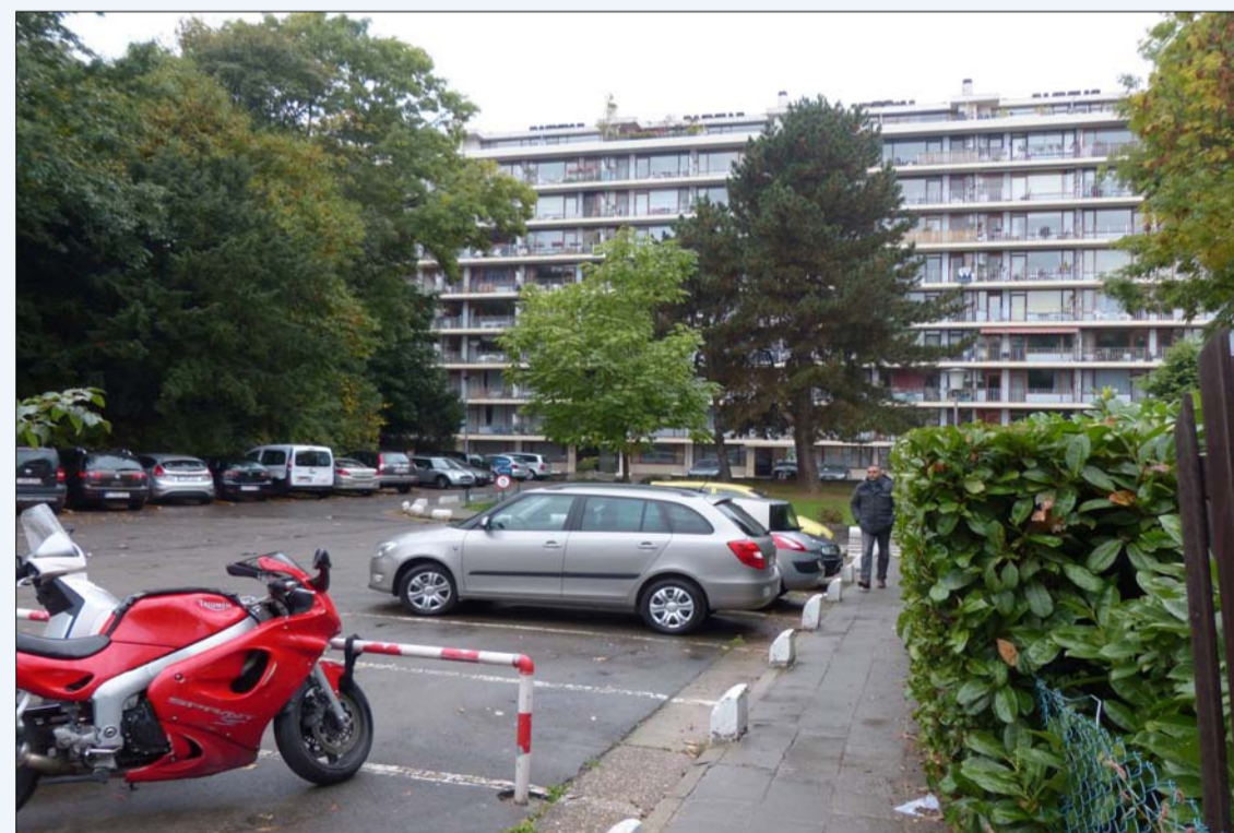
Résidence Wolvenberg : celle-ci comprend deux rangées d'immeubles qui ont pris la place des châteaux précédents (chaussée d'Alsemberg 1031-1033). Photo 2013.
