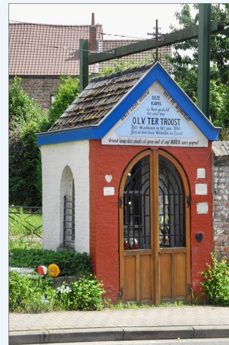
L'actuelle chapelle de Calevoet (face au n° 1435 de la chaussée), plus modeste que l'ancienne, démolie il y a près de deux siècles.
