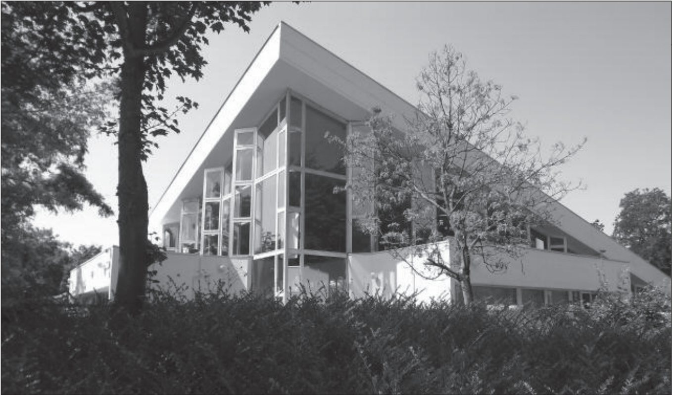
La pointe nord du toit suspendu de la piscine à sa hauteur maximale : 15 mètres.
