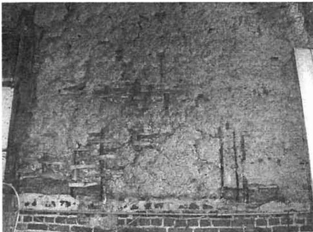
*Mur en torchis avec les palançons et le clayonnage horizontal, face sud.*
