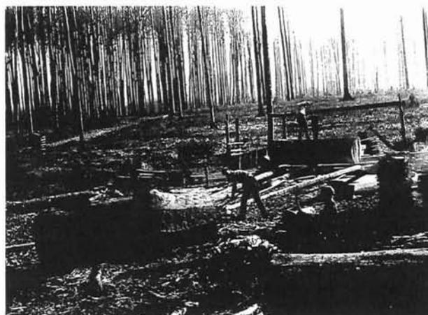
Scieurs de long en forêt de Soignes (photo Eaux & Forêts, 1897). On voit à droite le scieur tenant un des manches de la longue scie, – perché sur un énorme tronc, – l'autre scieur tenant l'autre manche au fond de la fosse.
