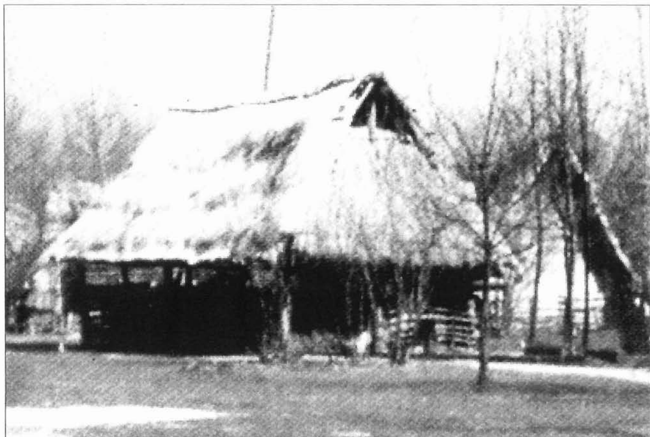
Maison de l'âge du fer (Archéosite Aubechies-Blicquy)
