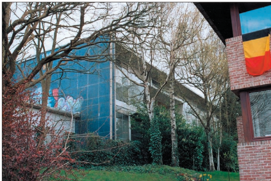
Pavillon C : façade droite (ouest) (photo 2008)
