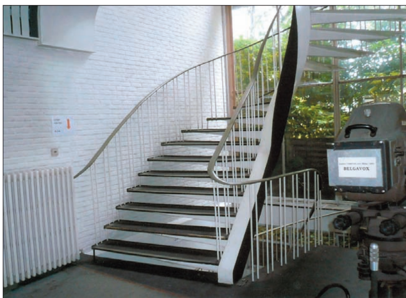
Pavillon C : escalier (photo L. Vannieuwenborgh 2008)
