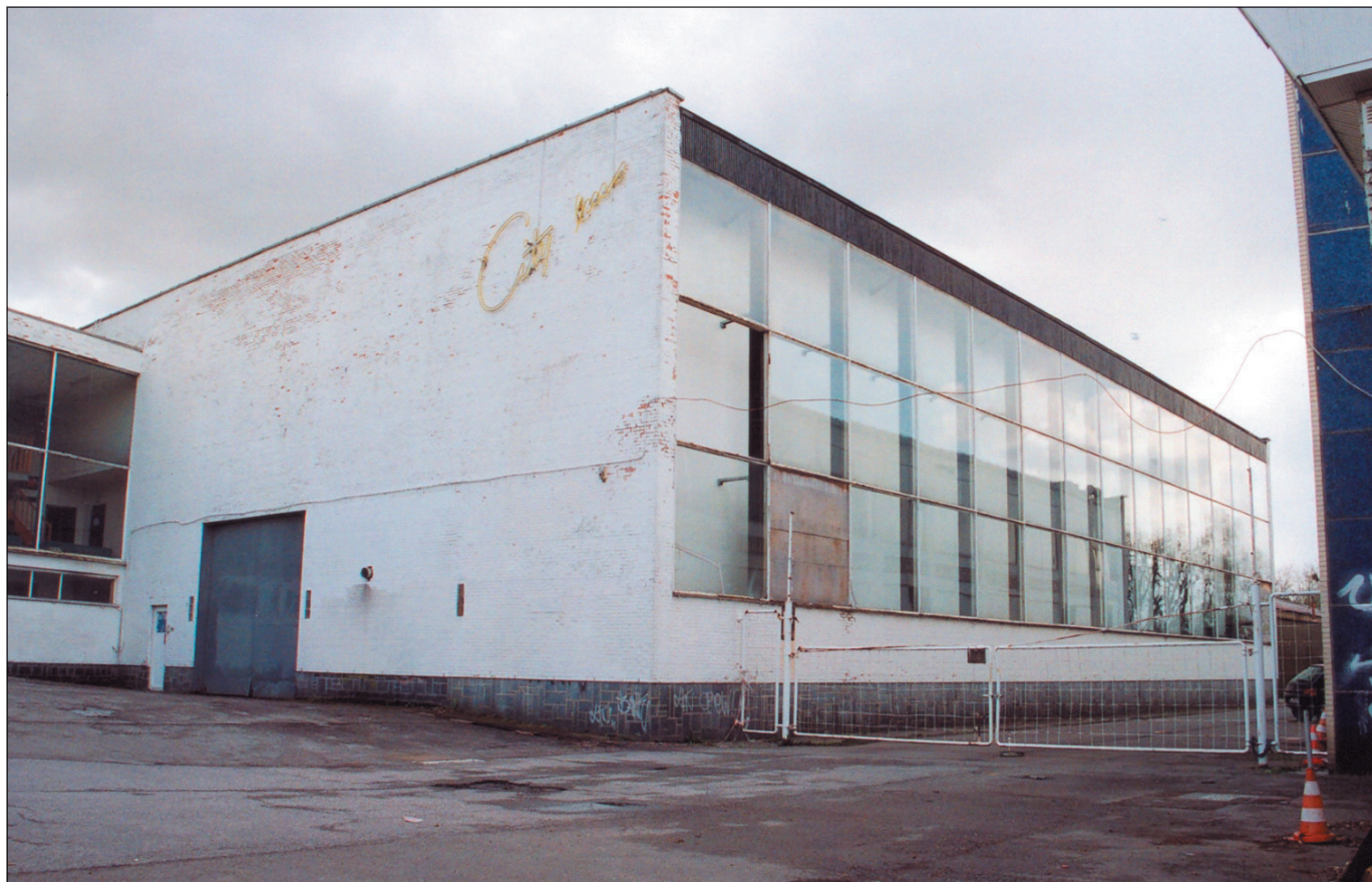
Pavillon B : rue de Verrewinkel 95 (photo 2008)
