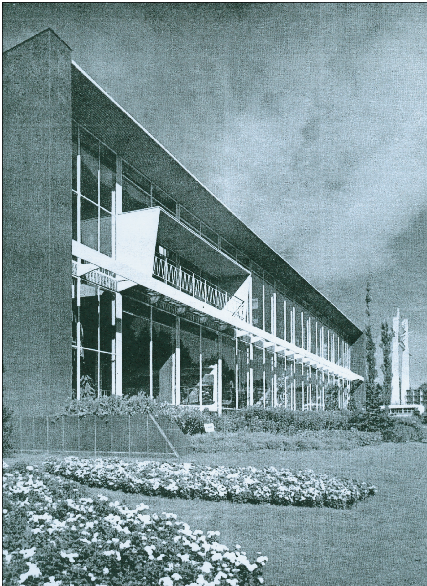
Pavillon C en 1958 : façade droite (Mémorial 3)
