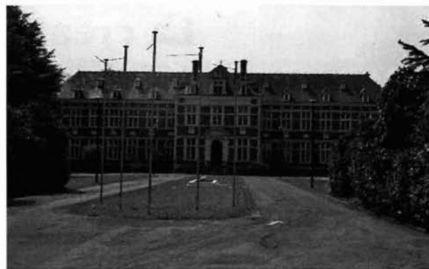
Façade principale (nord) de l'Institut Latour de Freins (rue Engeland 555) photo P. Ameeuw 2003
