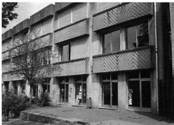
Vue actuelle de l'extension du Collège Saint-Pierre (à gauche du Bâtiment Corluy)
