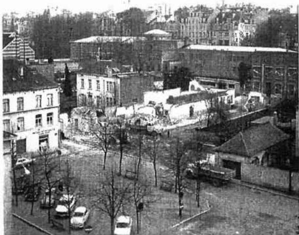
La démolition des anciens immeubles paroissiaux en 1970. Derrière les bâtiments en démolition, on reconnaît le Bâtiment Corluy et, à gauche de celui-ci, les anciens locaux scouts, très bas, démolis en 1973 pour faire place à une extension du Collège Saint-Pierre. À l'arrière-plan, la masse des bâtiments du même Collège. Coll. P. De Beys.
