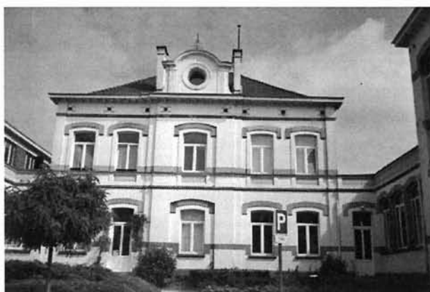
Vue actuelle du bâtiment central de l'École primaire communale du Centre.
