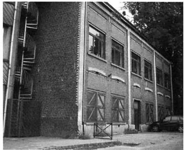
Vue actuelle du Bâtiment Corluy, à l'arrière du Centre Boetendael rue du Doyenné 96-98
