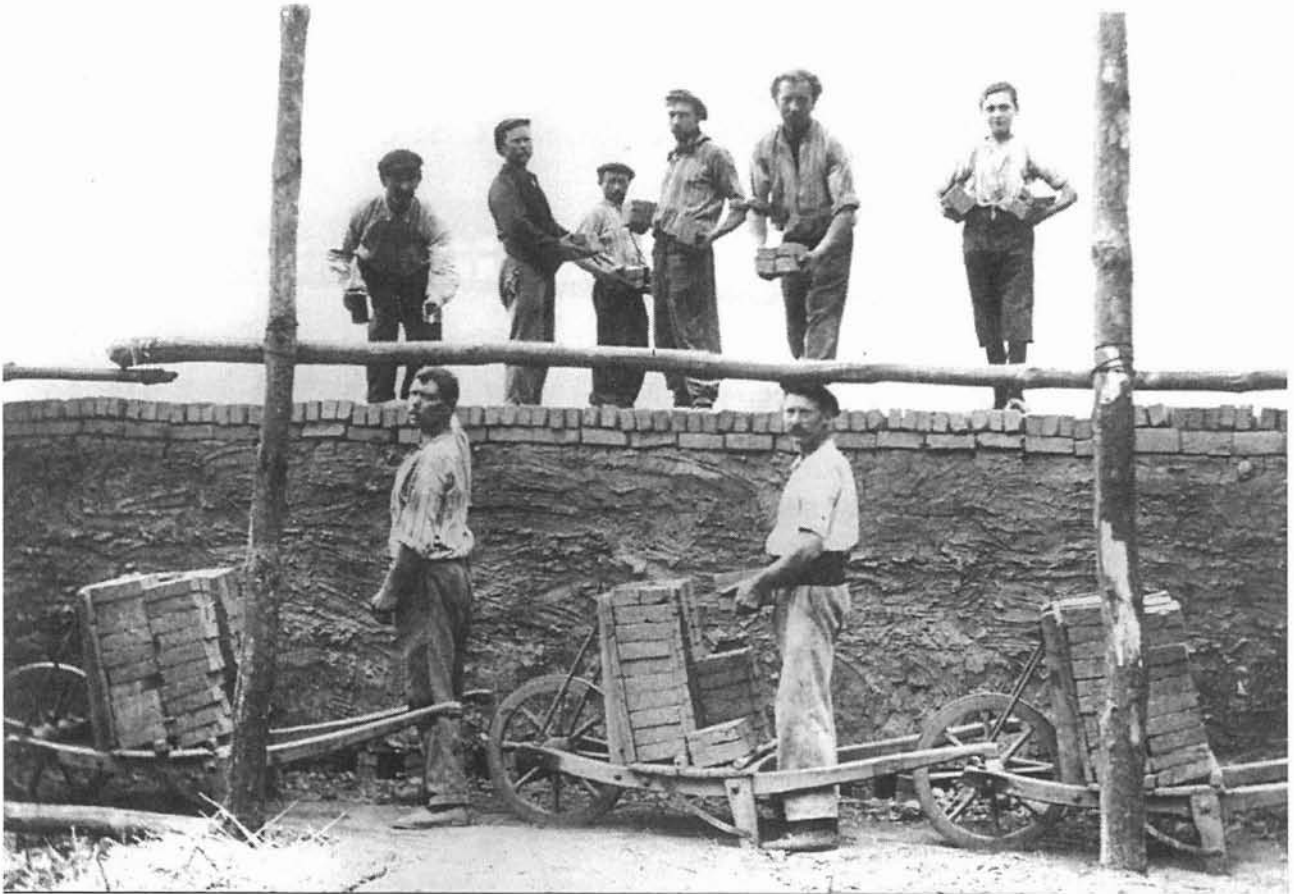
De bouw van een veldoven op de Hulstberg te Meerbeek voor 1914 (Collectie 1000 jaar Meerbeek)
