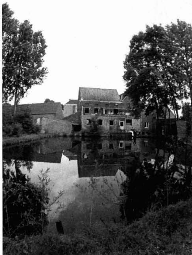
L'arrière des bâtiments, avec l'étang (coll. P. Algoet)
