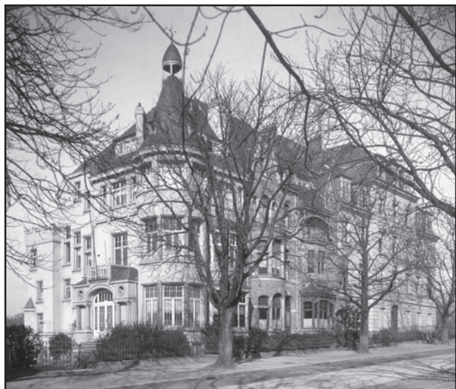
Les bâtiments bordant l'avenue Coghen, avec l'internat (sans extension), à partir du sud.
